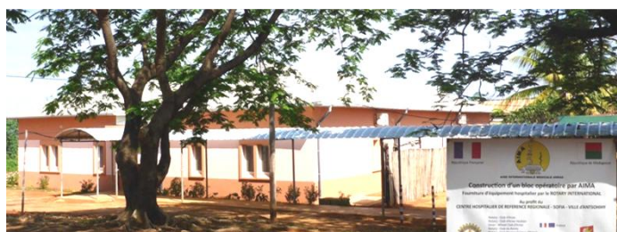
Le nouveau bloc opératoire
